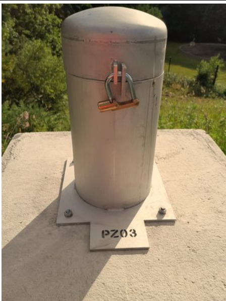
Réalisation des piézomètres au barrage de Guerlesquin
