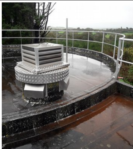
Mise en sécurité réservoir de Plounéour-Menez
