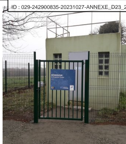
Remplacement clôture réservoir de Kerglaz à Plougonven
