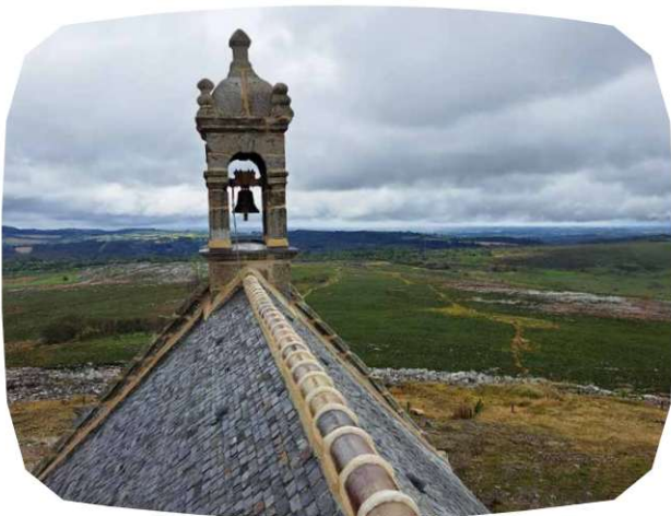
Restauration des tuiles faïtières © Coadou couverture
